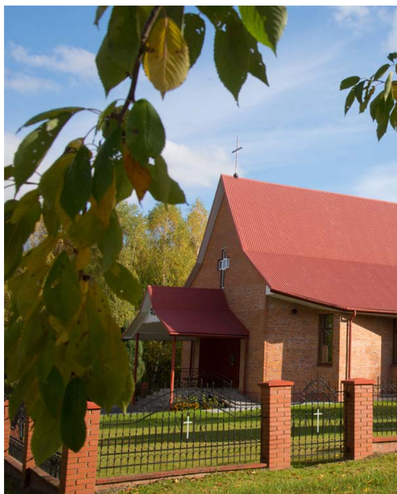
Kaplica w Dąbrowie
