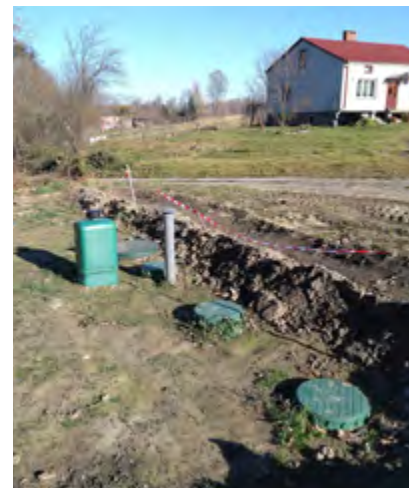
Oczyszczalnia w Antoniówce
