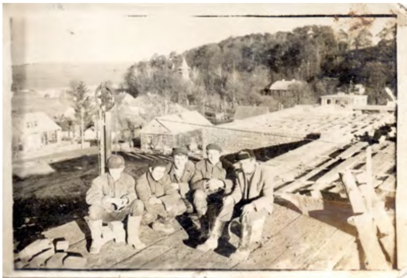
Widok z budowy szkoły w Krynicach. Archiwum rodziny Wilanowskich.
